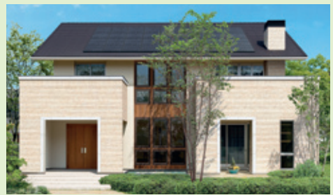
太陽電池モジュールを設置した住宅
